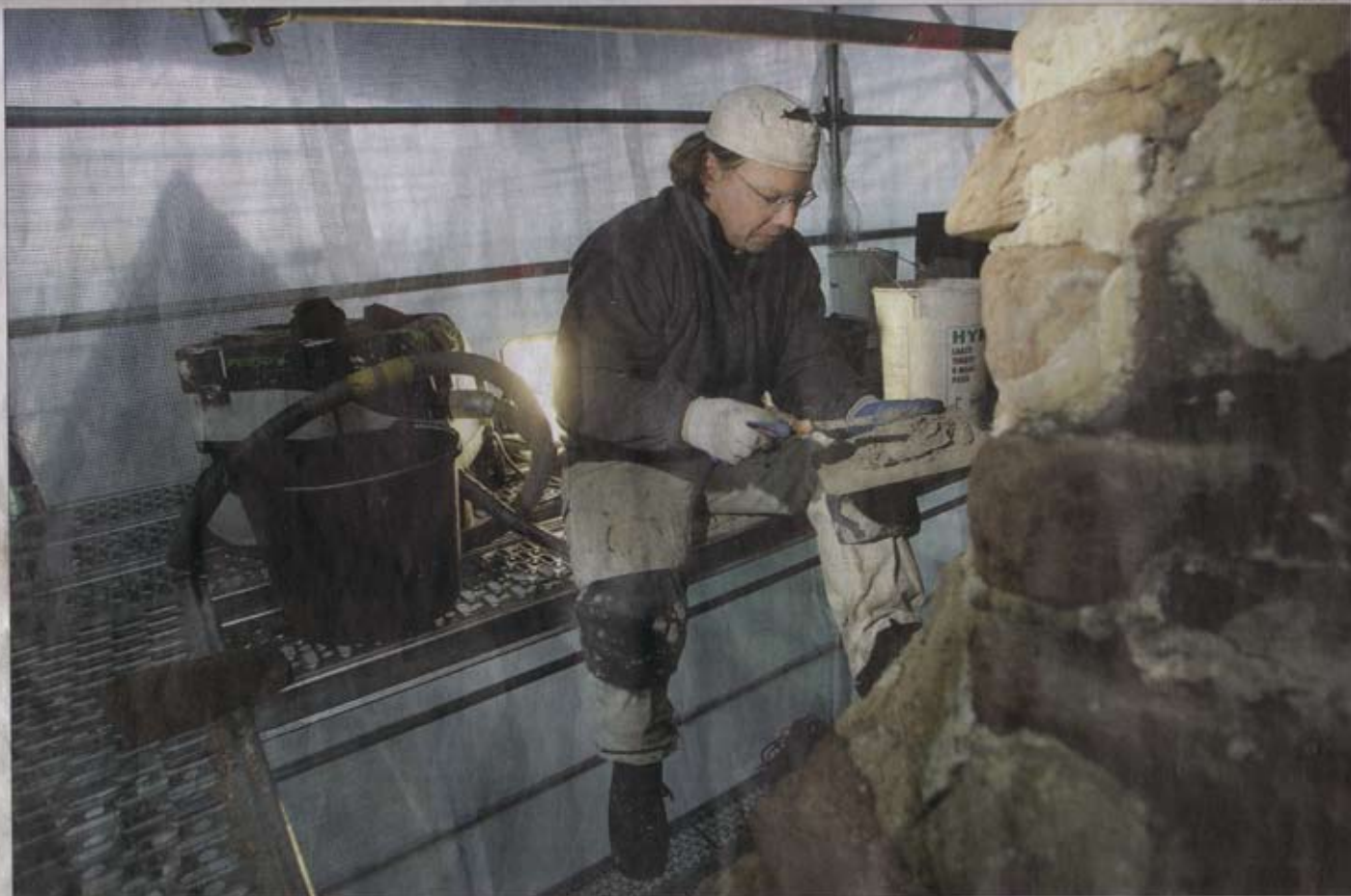
Jukka Kinnunen saumaa noin 30 metrin korkeudessa huokeissa maisemissa, vaikkakin harsopitteen sisällä. "Tämä on tosi mielenkiintoista, kyllä tällainen spesifi homma voittaa aina tavalliset rappautyöt", mies tuuraa. Hänen mukaansa on haastavaa työskennellä vanhoilla laasteilla, joita ei käytetä muilla rakennustyömailla enää. "Aika menee täällä ylhäällä tosi nopeasti."
